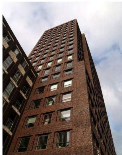
Metselwerk rasters en dieptewerking Kollhoff toren - Hans Kollhoff - 1999
