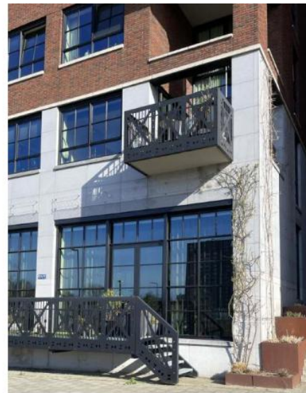
Verfijning stalen hekwerken en kozijnen met roeden. Little C Rotterdam - INBO - 2020
