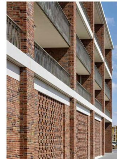
Opengewerkt metselwerk parkeergarage South Gardens Elephant Park - Maccreanor Lavington - 2025
